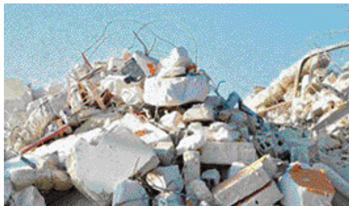
14 - Recyclage des matériaux de démolition
