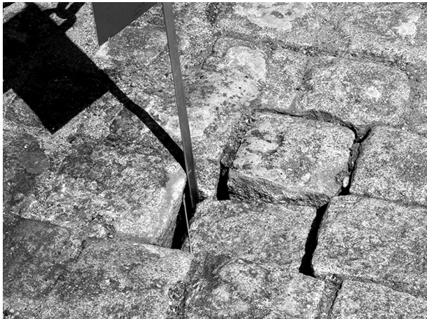
Photo 3 : Quai Cassard, pavés disjoints révélant un sable humide sous-jacent - Photo Paul Bernier
