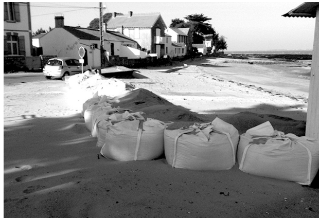
Photo 9 : Le Vieil. Défense souple et mobile contre la mer par des sacs de sable et un monticule avant Photo Fanny Potier
