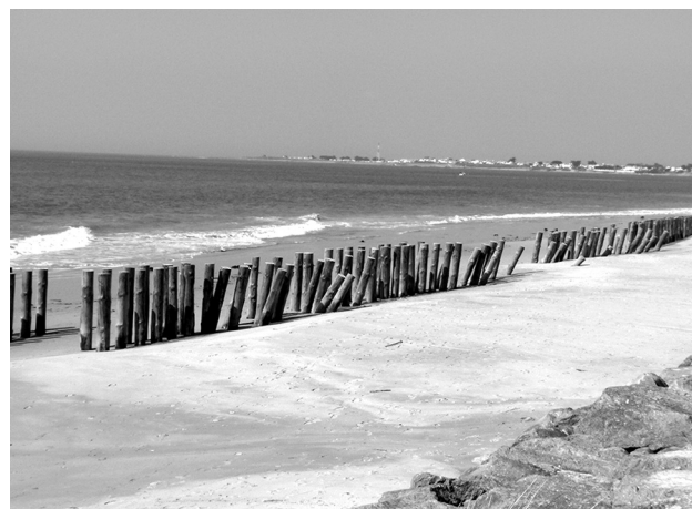
Photo 8 : Luzéronde. Les pieux résistent et sont toujours efficaces. Ils ont été redressés depuis cette photo (avril 2015) - Photo Paul Bernier
