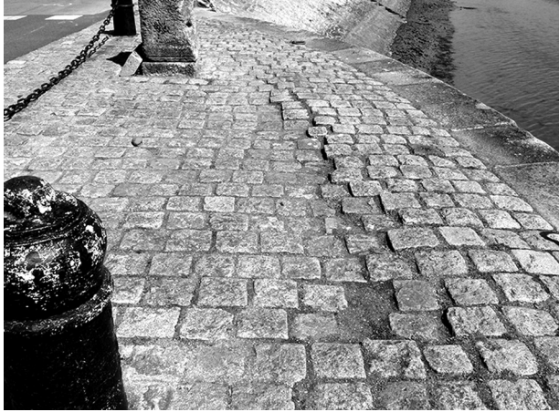
Photo 3 : Quai Cassard, affaissement de la chaussée en pavés - Photo Paul Bernier
