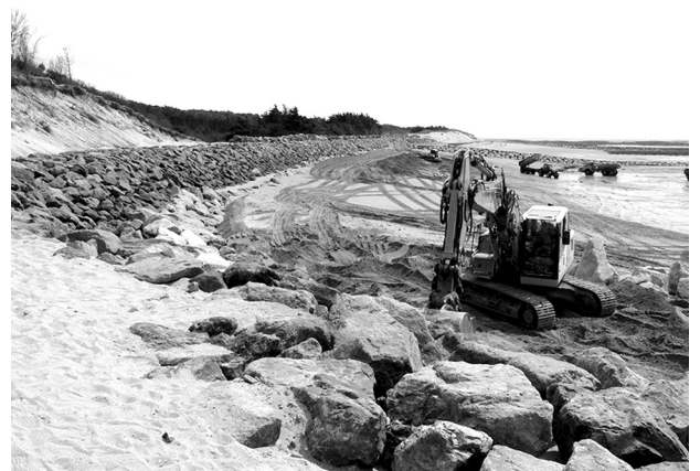
Photo 6 : Les Eloux, nouveaux blocs et apports sableux confortent l'enrochement temporaire (avril 2015) Photo Paul Bernier
